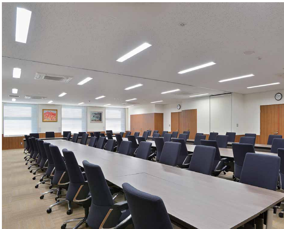
LEDベースライトAQシリーズ埋込形を5台×5列でレイアウトして約700ルクスの平均照度が確保された商工会議所特別会議室
