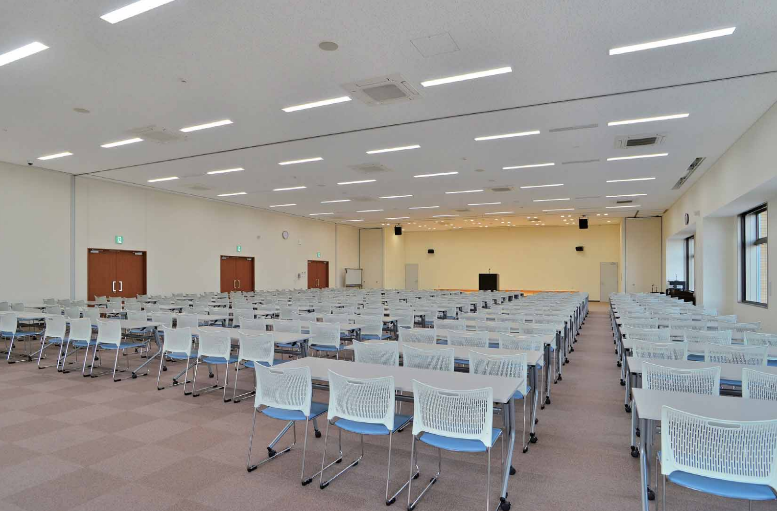
最大270名収容可能な6階大ホールの照明 LEDベースライトAQシリーズ埋込形を整齐配置
