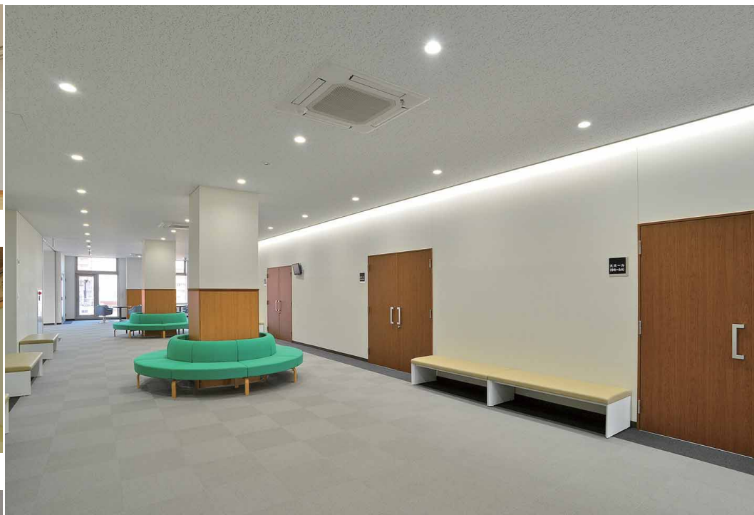
6階ホール前ラウンジの照明 ベースにLEDライトエンジンダウンライトを、壁面にはLED間接照明を採用
