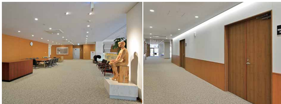
2階ラウンジには埋込穴φ100のLEDライトエンジンダウンライト1100クラスを整列配置
