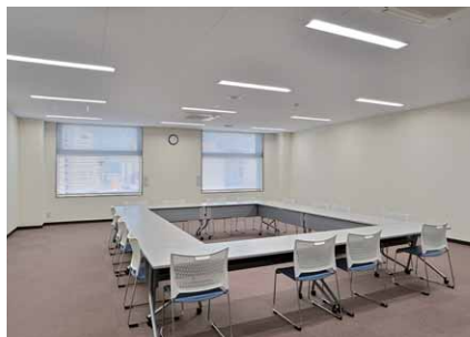
5階貸会議室の照明
