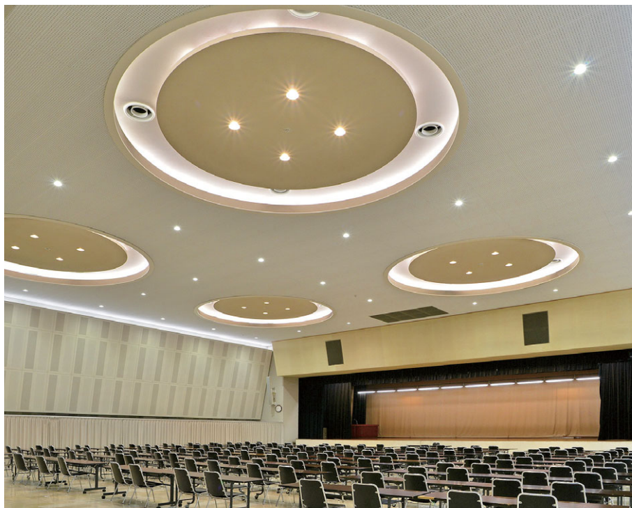
改修された講堂の照明 4か所の同心円状のコーブ間接照明が設けられており、円の外側にはLEDベースライトトラフ器具を、中央にはLEDダウンライトを配置
