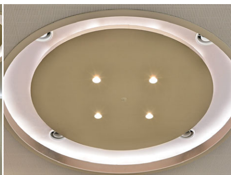
同心円状の間接照明にはLEDトラフ器具とLEDダウンライトを使用
