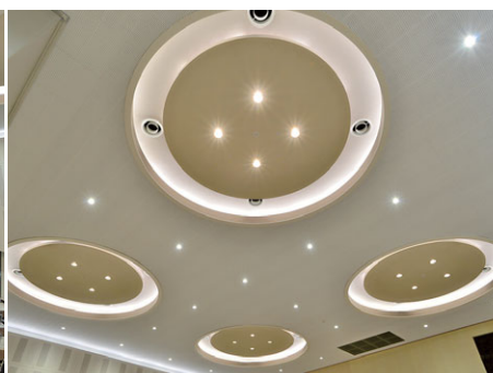
4か所に設けられた直径約5mの同心円状のコーブ間接照明
