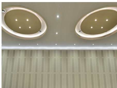
壁面に採用したLEDトラフ器具による間接照明
