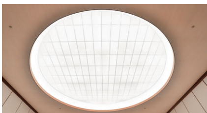
議場席の天井に設けられている直径12mの円形コブ照明
