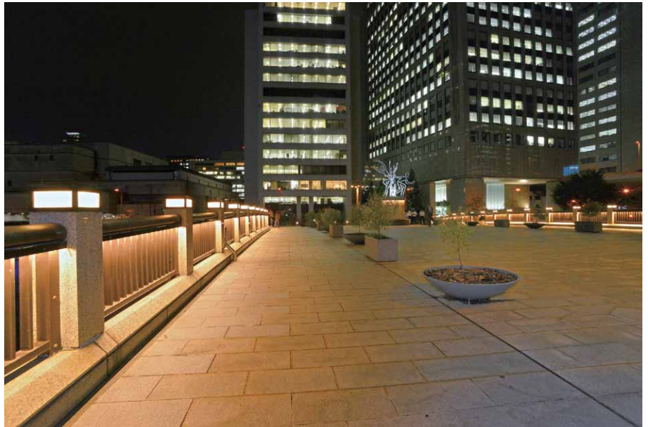
欄干の手すり下部、柱の上部に配置された電球色のLED器具により統一感のある光空間を創出
