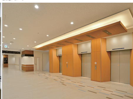
LEDダウンライトとLED間接照明採用のエレベーターホール
