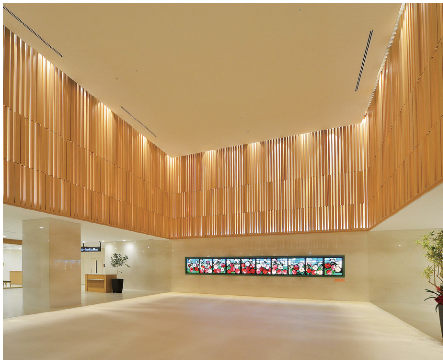
エントランスホールは壁面の縦格子が取り囲む意匠にLEDダウンライトとLEDアップライトを組み込んだ建築化照明
