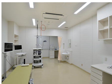
LEDベースライトTENQOOシリーズカバー付器具を設置した診察室
