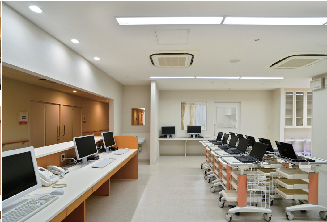
スタッフステーションにはLEDベースライトTENQOOシリーズとカウンター上にLEDダウンライトを設置
