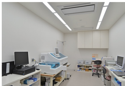
検査室のLED照明
