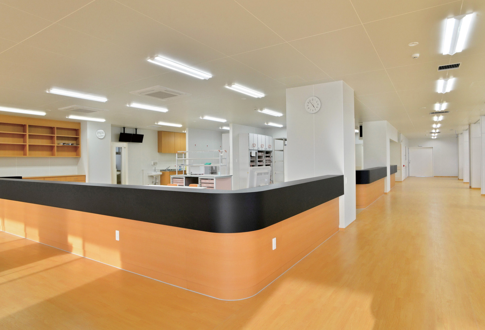
LED薄形ベースライトをライン配置した廊下とスタッフステーション
