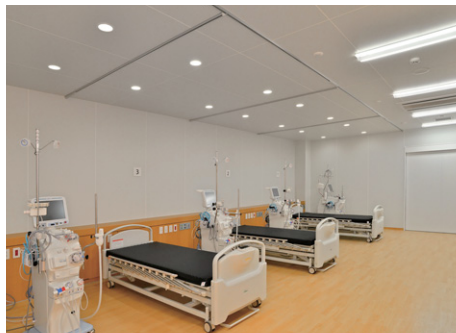
ベッド側にはダウンライトを、スタッフの通路側にはLED薄形ベースライトを配置し、光環境を付けた血液浄化治療室
