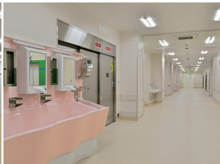
患者が眩しさを感ぜないよう壁沿いにLED薄形ベースライトを配置した手術室前の廊下
