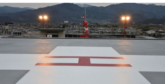
着陸区域照明灯、風向灯、埋込形標識灯など、緊急離着陸場照明システム一式が設置された屋上ヘリポート
