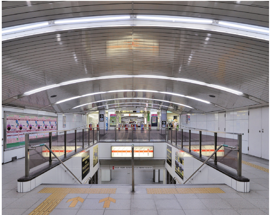
改札階コンコースの天井照明も直管形LEDベースライトへ更新
