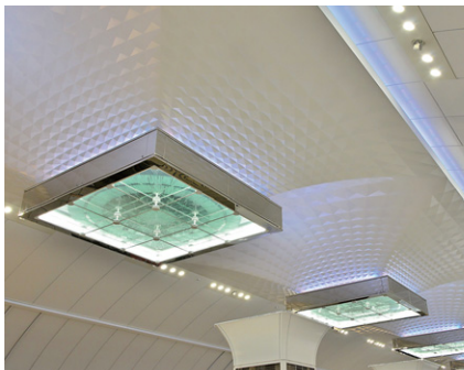
LEDフラッドライトの様子
