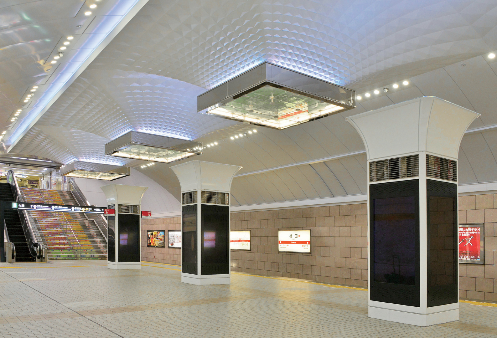
LEDダウンライト等の主照明に加え、フルカラーLEDフラッドライトと棒状フルカラーLEDライトによる演出照明を備えたアーチ空間
