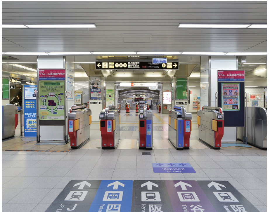
改札周辺のLED照明
