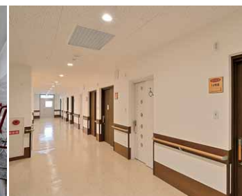
居室廊下のLED照明
