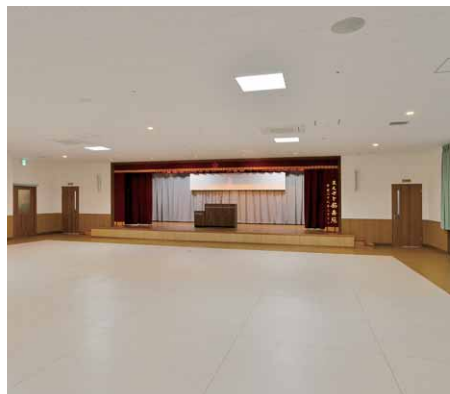
ステージ付多目的ホールはON/OFF制御のTENQOOスクエア器具と調光制御のLEDダウンライトを設置
