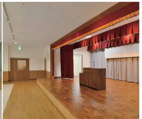
ステージ用の演出照明にLEDスポットライトを天井に配置
