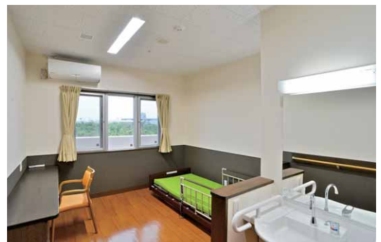
居室に設置されているLED照明
