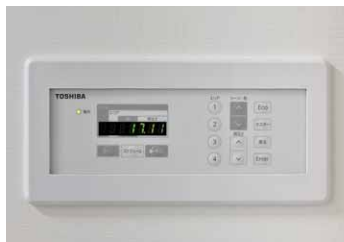
SESL照明制御コントローラー
