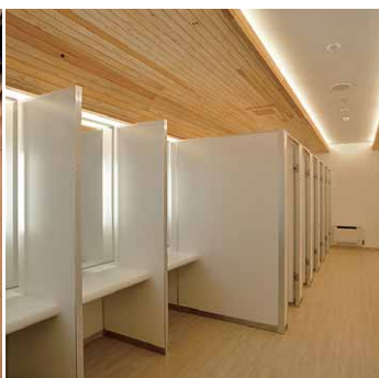
トイレ&パウダールームのLED照明
