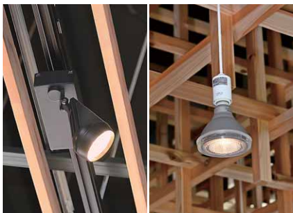
特産品売場のLEDスポットライト(左)とレストランのLED電球ビームライト(右)
