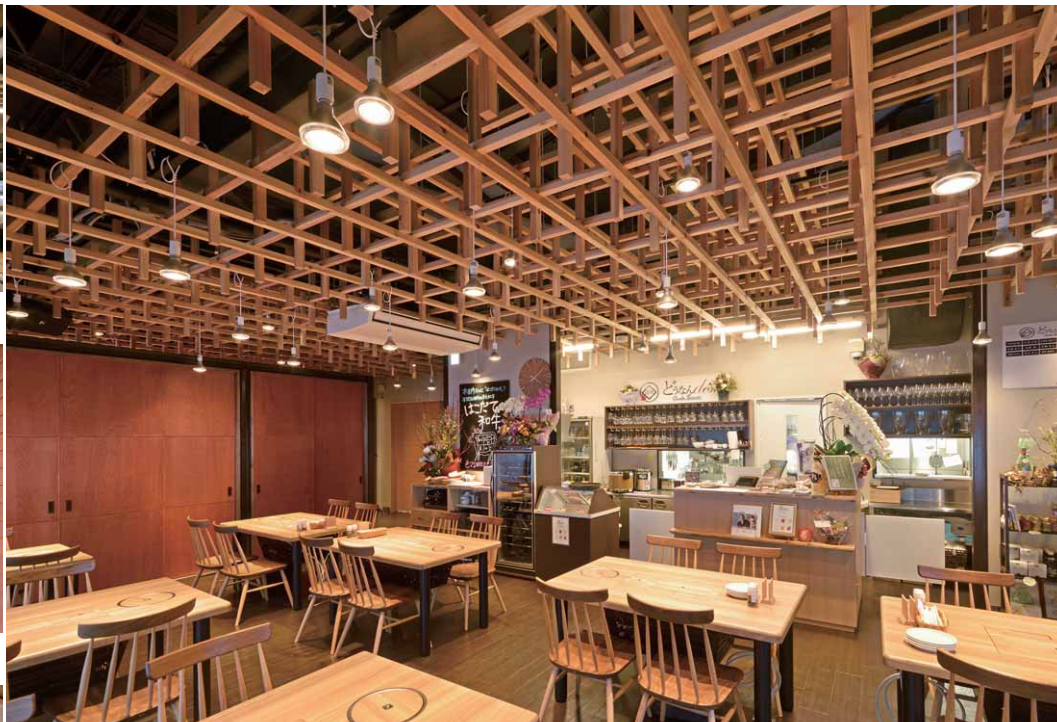
LED電球ビームライト高演色形を木組天井にランダムに配置したレストランの照明
