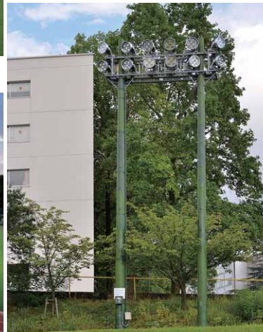
14m高の照明塔にLED投光器を搭載(昼間の消灯時)
