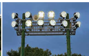
照明架台に搭載したLED投光器(夜間の点灯時)
