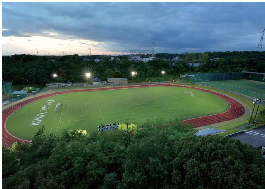
メイングラウンド前の72号館屋上より望む照明塔8塔(合計80台のLED投光器)によるナイター設備の点灯時
