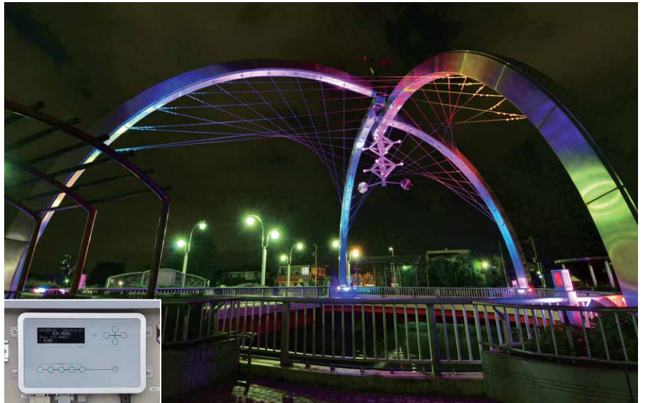
モニュメントを橋上から見上げる。シーン設定はレインボーカラーの「祭り」、左下はLED演出照明制御盤
