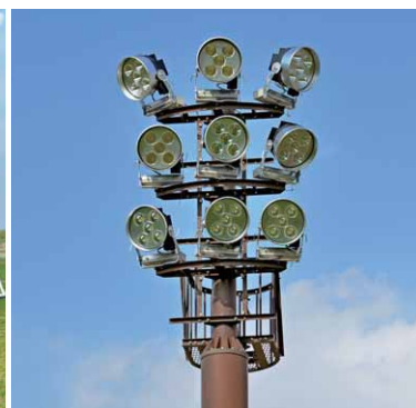
消灯時のLED投光器搭載の照明柱
