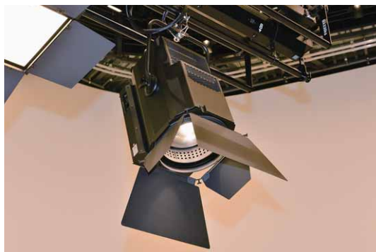
国内初 ※ となるハロゲン器具3kW相当のLEDスポットライトを新規開発
