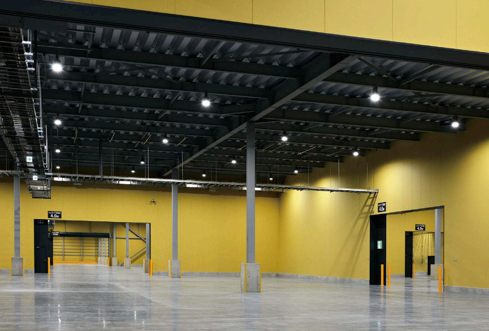
特注仕様のLED丸形高天井器具を千鳥配置で設置した2階流通倉庫
