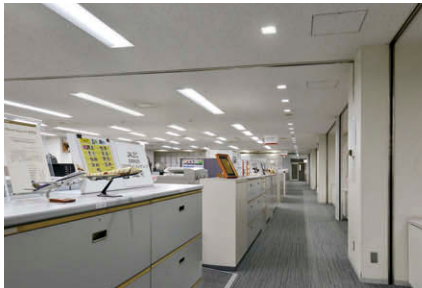
通路にライトエンジンダウンライト角形、執務スペースにTENQOO埋込形を配置したオフィススペース
