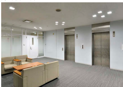
エレベーターホール 既設の角形ダウンライトの取付穴に合わせて設置されたLEDライトエンジンダウンライト角形
