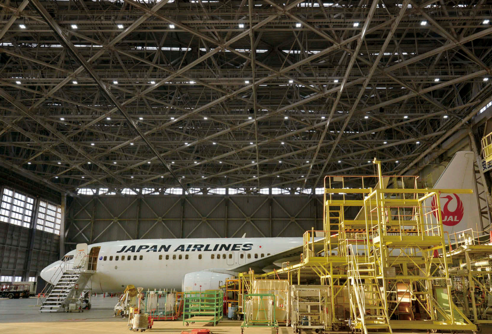
軽整備と日常的なメンテナンスを行うM2格納庫のLED高天井器具
