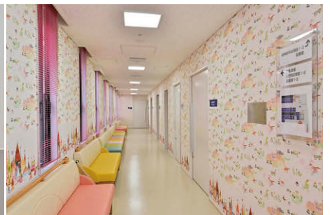
LEDベースライト一体形スクエア器具による1階の小児科診察室の廊下の照明
