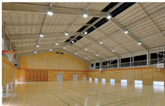
ステージ側からエントランス側を望む リニューアル後の平均照度は600～650ルクスを確保
