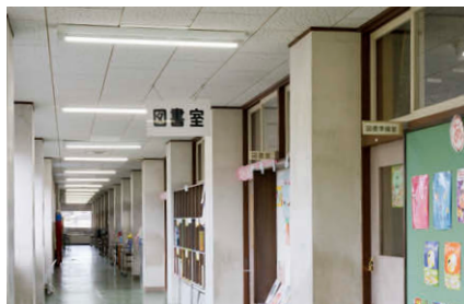
LEDベースライトTENQOOシリーズ直管形を配置した廊下、校舎中央付近から東側を望む
