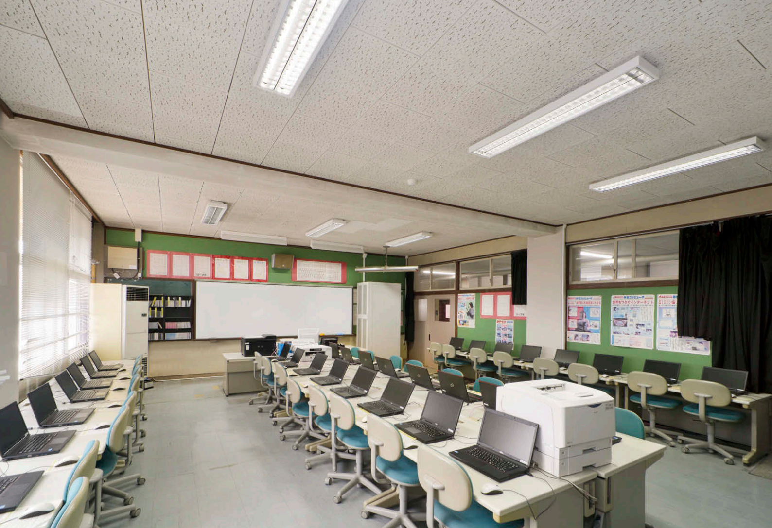
画面への映り込みを防止するため高効率OAアルミルーバー付直管形LEDベースライトを配置したパソコン室
