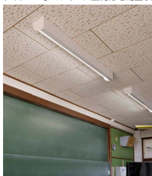
角度切替可能形のTENQOOシリーズ直付形黒板灯を使用
