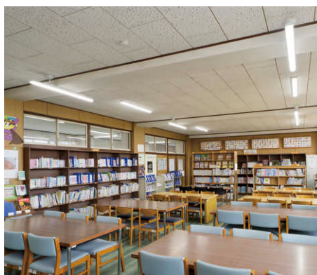
梁と重なる箇所では吊下アダプターを使用し、LEDベースライトTENQOOシリーズ直付形を配置した図書室
