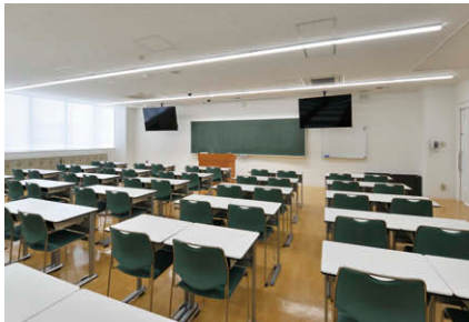
TENQOOシリーズ直付器具連結設置によるライン配置の歯科衛生士専門学校の一般教室
