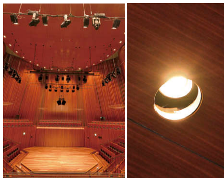
(左) 神戸女学院 小ホールのLEDスポットライト、(中) 神戸女学院 小ホールのシアター用LEDダウンライト (右) 右手側に360本のプリセットフェーダーを配置し演劇向け照明の操作性を高めた、阪急 中ホールの調光操作卓
