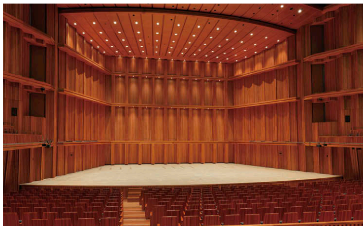
シアター用LEDダウンライトが配置された舞台上の天井反射板
