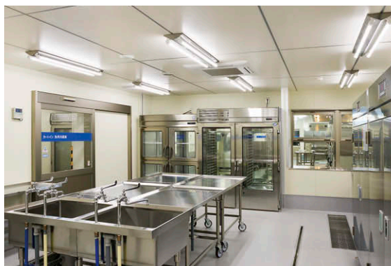
防湿タイプの直管形LEDベースライトによる中学校用ゾーンの魚肉下処理室の照明
