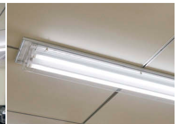
直管形LEDベースライト(直付2灯)のHACCP・クリーンルーム兼用形器具
