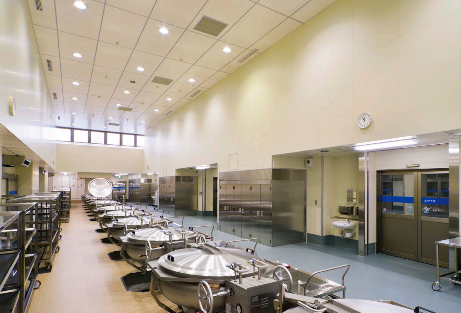
直管形LEDベースライト(直付2灯)のHACCP・クリーンルーム兼用形器具とHACCP特注仕様のLED一体形ダウンライトを採用している小学校用ゾーンの調理室
