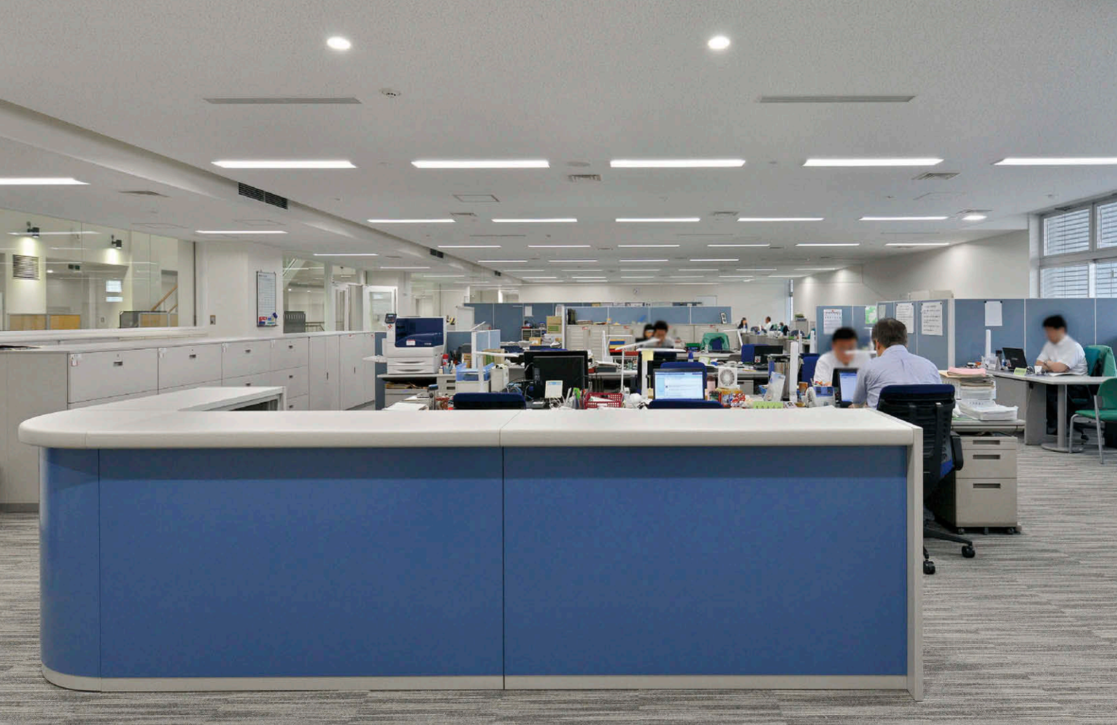
執務室の照明は「タスク&アンビエント照明」+自動でブラインド制御された自然採光を「あかり+人感センサー」により照明制御を行い、執務に必要な照度の確保と、不在検知により減光・消灯制御
