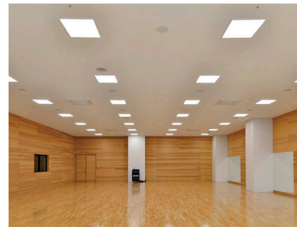
多目的室 上向きになっても目に負担を感じないアクリルカバー付きのベースライト一体形スクエア器具③を採用（照度500ルクス）
