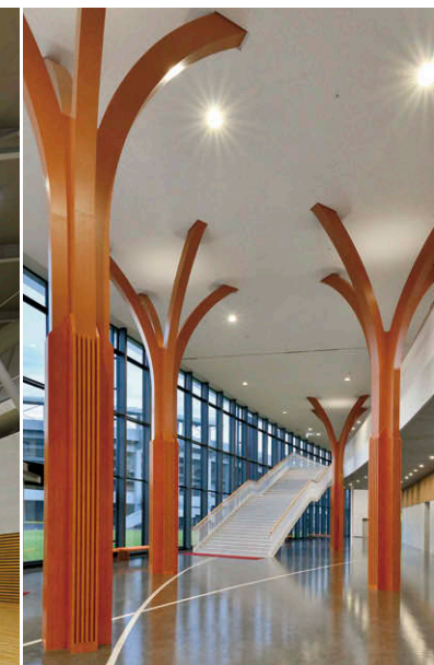
エントランスホール 木に模してデザイン化し、その木に仕込んだ照明で天井面を照射
