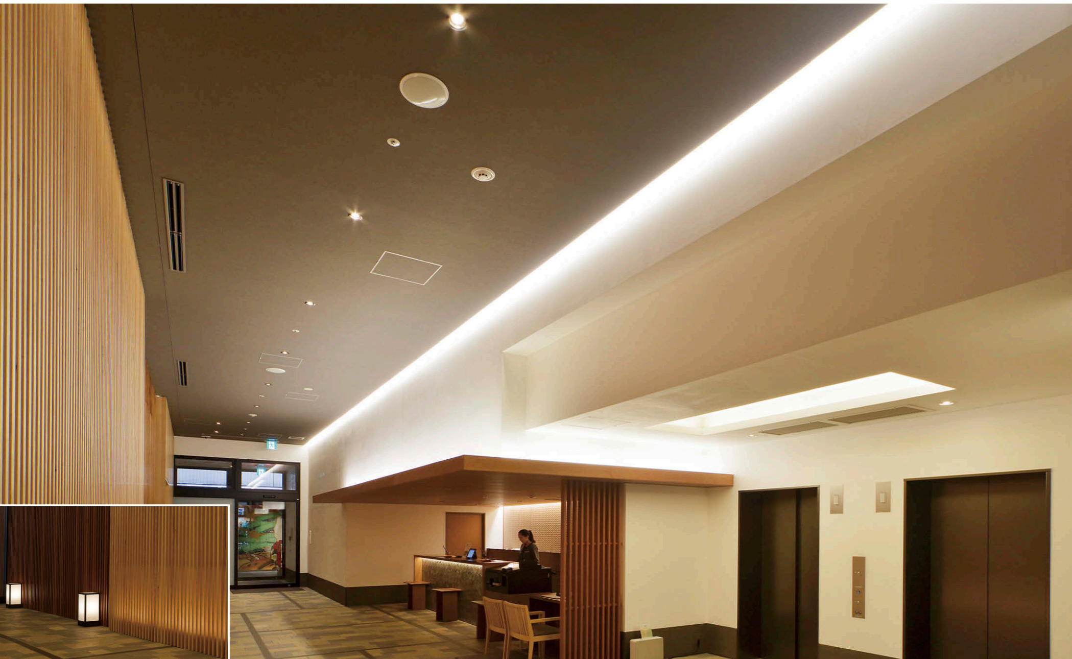
南館ロビーの照明 電球色のLEDダウンライト①/LEDユニバーサルダウンライト②およびLED間接照明③が落ちつきあるシックな照明空間を創出。
