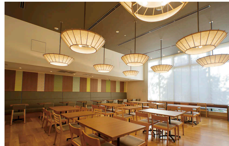
南館1階カフェレストラン ペンダントには一般電球形LEDランプを採用。天井の入口付近および窓側には明るさバランスを考慮してLED一体形ユニバーサルダウンライト④を計10灯配置。
