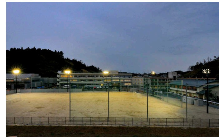
グラウンド正面から望むLED投光器による夜間照明
