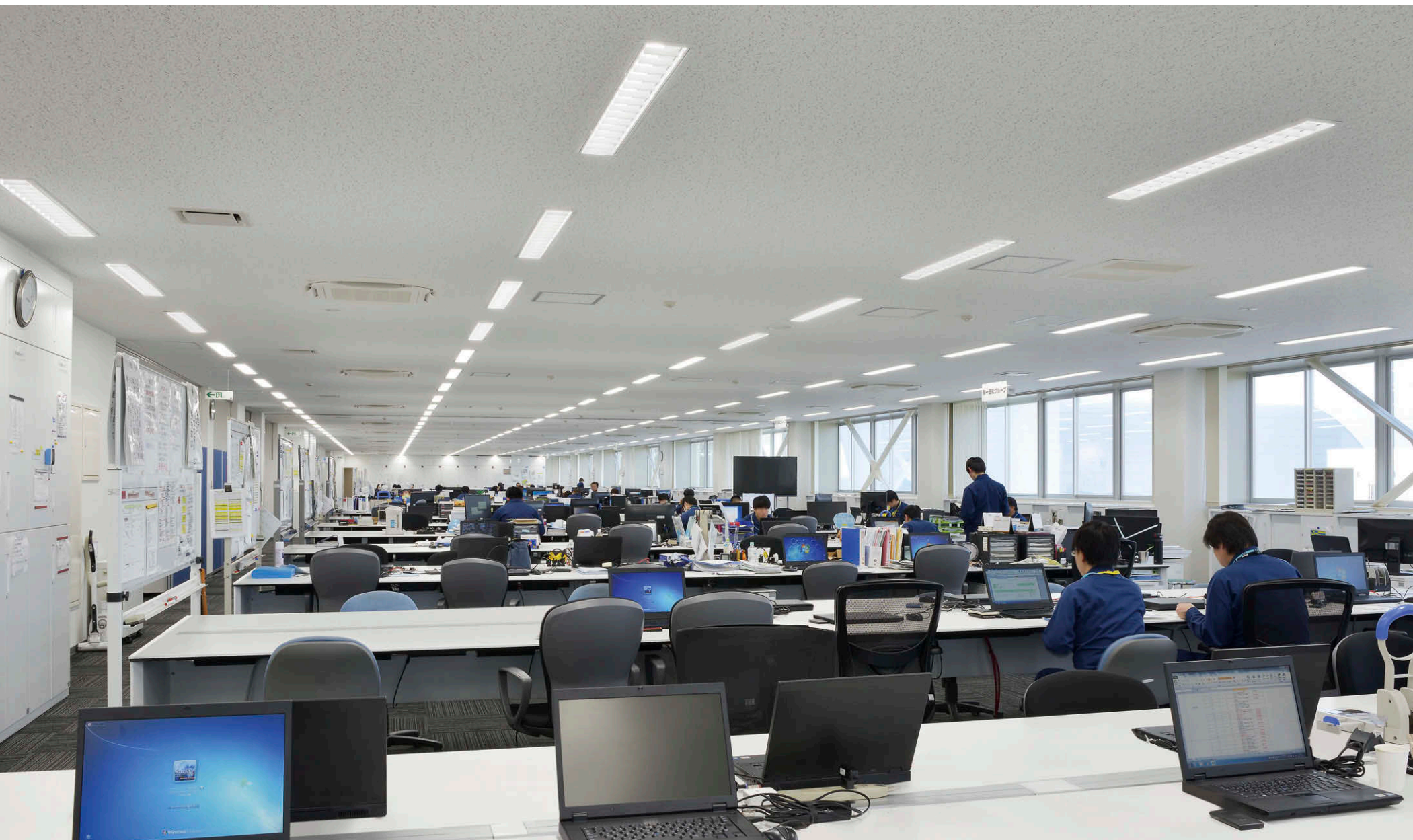
2階のオフィススペースの照明 TENQOOシリーズ埋込形①②平均照度を高めに設定し、グレアを抑えるLEDバーを採用し、明るく快適な執務環境を創出
