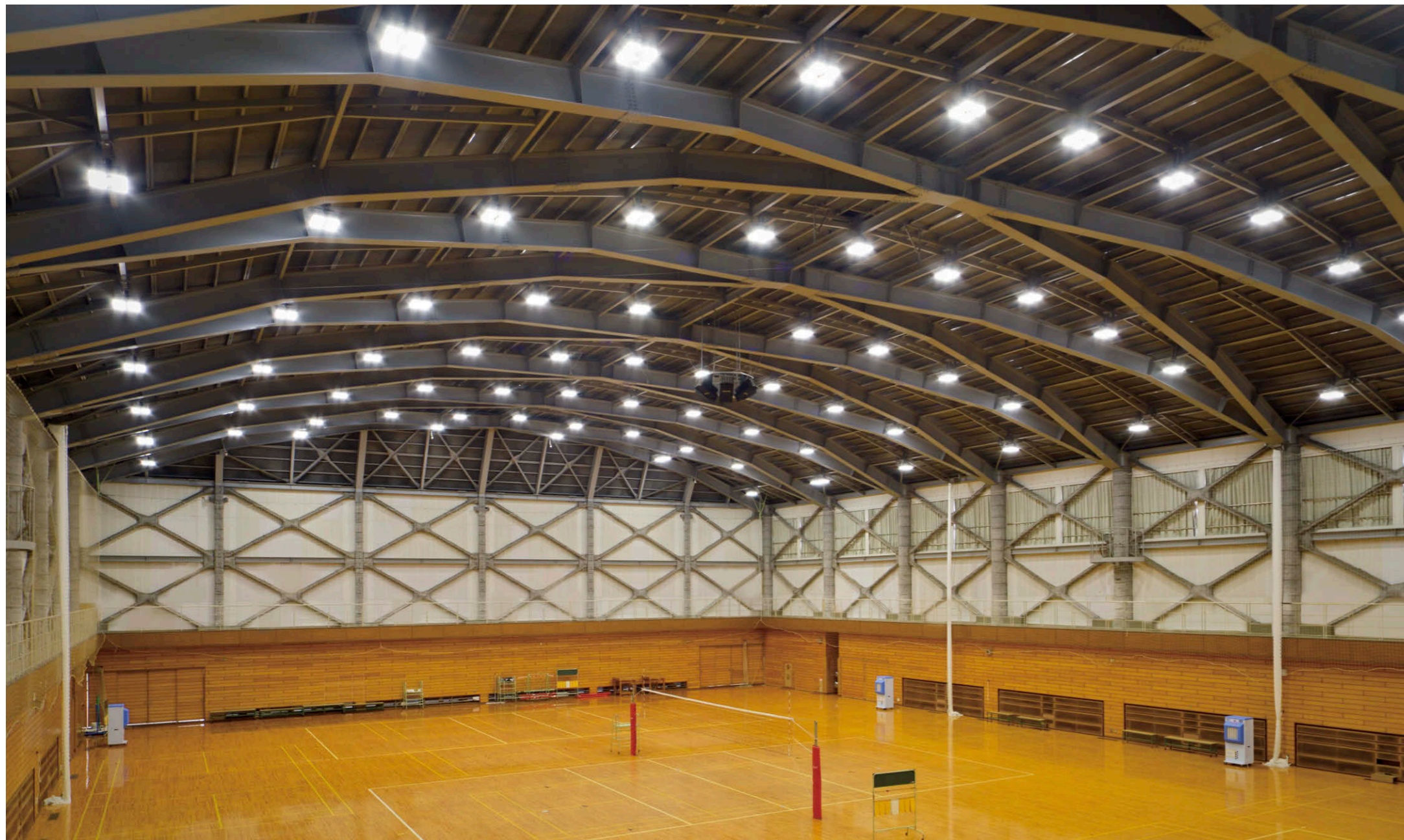
Bアリーナの照明 LED高天井器具②に拡散カバー付下面ガード③を装着。上方を見上げる競技に適した照明環境を創出
