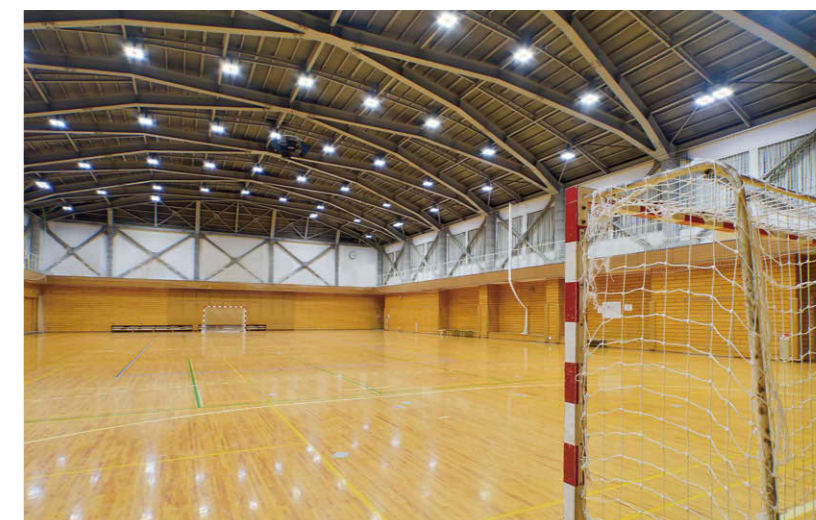
Cアリーナの照明 2015年にLED高天井器具②へ更新。主にハンドボール、器械体操、フェンシングなどに使用
