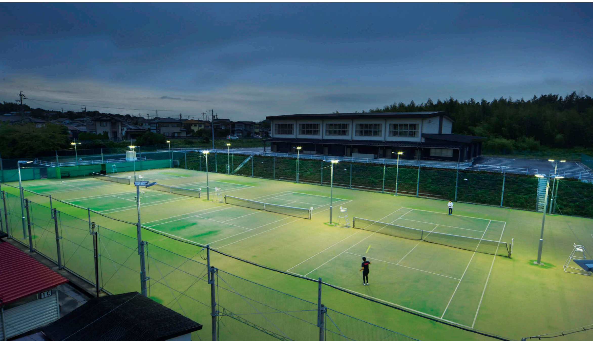
夜間点灯時のテニスコート全景 コート間には4灯用を、ベースラインサイドには2灯用を配置
