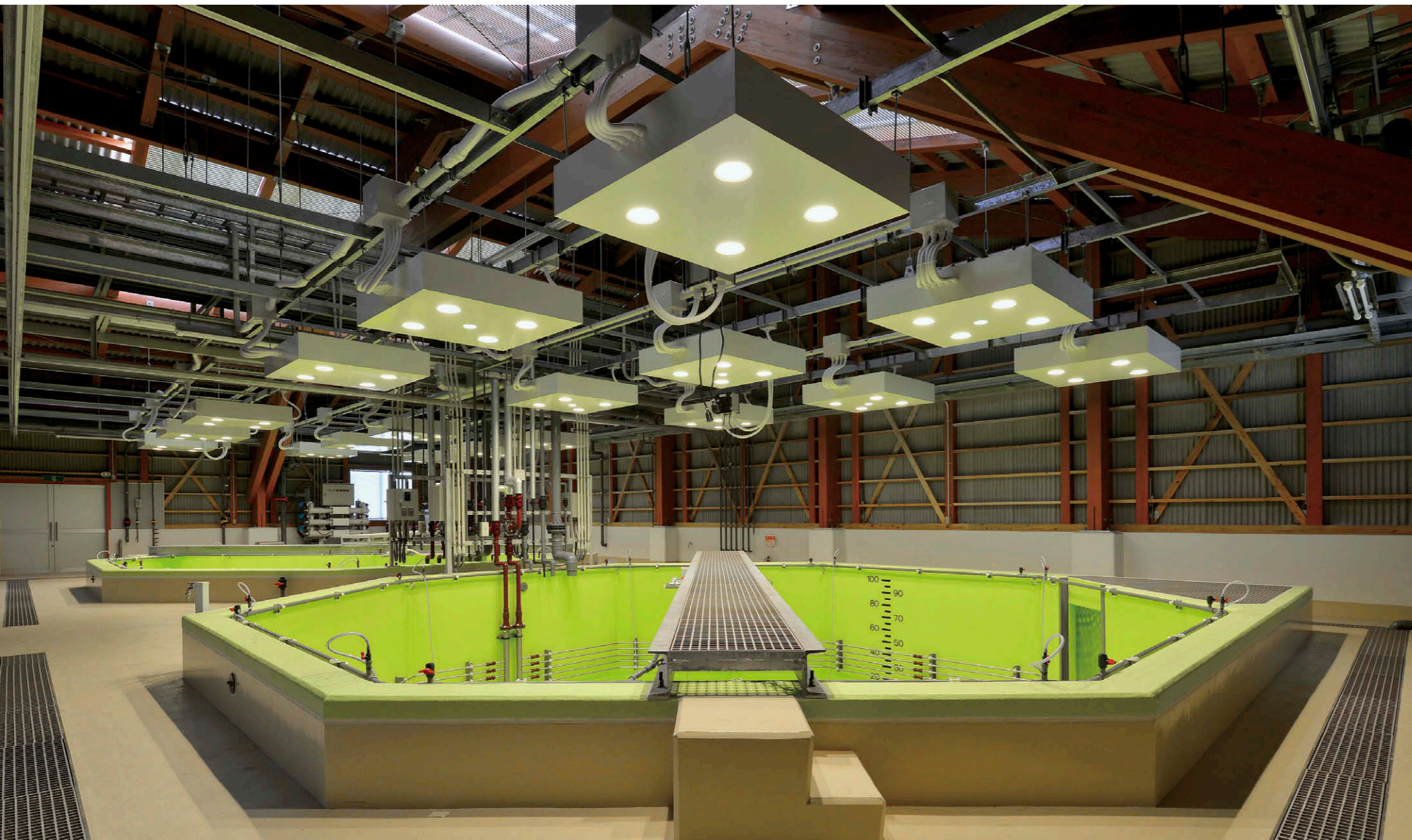
親魚用水槽の照明 日中を再現した全点灯（調光100%） ①②③④⑤
