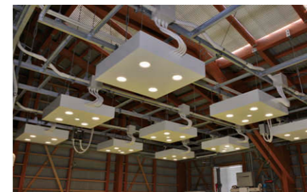
親魚用水槽の照明 照明ボックスに収納したLEDライトエンジンダウンライト④+生理検査室LEDダウンライト⑤（日中）
