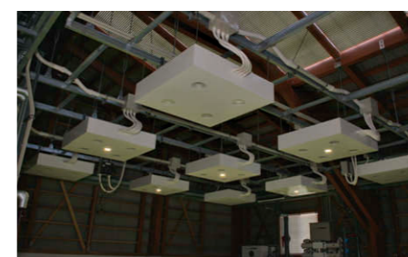
親魚用水槽の照明 生理検査室LEDダウンライト⑤による調光5%の照明（夜間）
