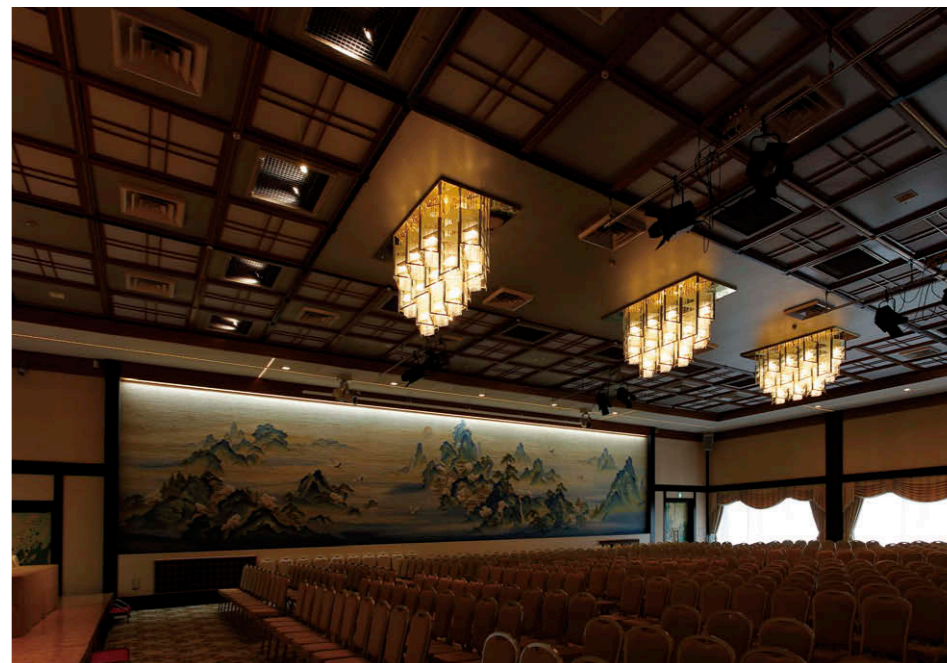
ベース照明を消すと低色温度の器具が現れ、窓から見える庭園の自然色とマッチした空間雰囲気へと変化③④
