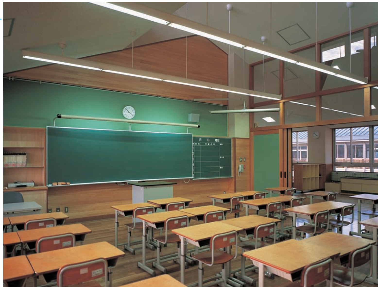
3階普通教室の照明：32WHf蛍光灯1灯用5連結下面ルーバ付吊り下げ器具を採用。快適な学習環境を創りながら開放感を高めている
