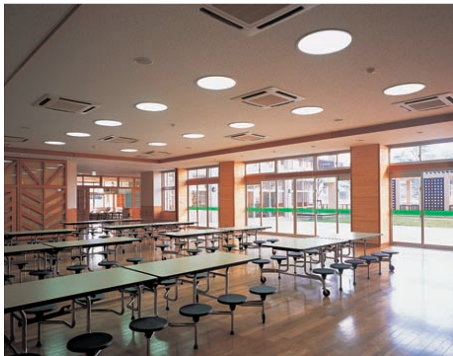
1階多目的スペースの照明：55Wコンパクト形蛍光灯下面乳白カバー付埋込器具を配置。柔らかな豊かな親しみ感のある照明環境を創り出している
