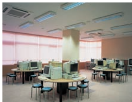
パソコン教室の照明：OAルーバ付直付器具を採用し、目の負担を軽減しながら明るい視環境を確保
