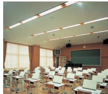
音楽教室の照明：32WHf蛍光灯2灯用埋込器具を木製のスリット内に採用。すっきりとした明るい視環境を確保
