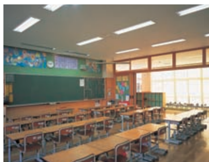
1階普通教室の照明：32WHf蛍光灯2灯用下面開放形埋込器具を採用
