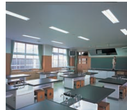
理科教室の照明：32WHf蛍光灯2灯用埋込器具（バツフル付）を整列配置
