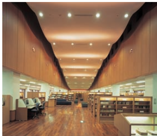
図書館の照明：館内通路の高天井には42Wコンパクト形蛍光ランプダウンライトを、壁面には35W CDM-Rスポットライトを配置
