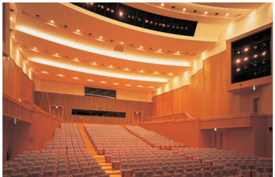
ホール客席の照明：ベース照明にハロゲンランプダウンライトを採用し、さらに間接照明で空間全体に広がり感を創出
