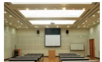
多目的研修室の照明：間接照明、ダウンライト、スポットライトを配置し、多目的利用に対応可能としている
