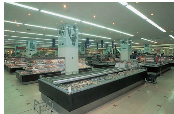
1階マーケットゾーン Market zone on the 1st floor FL110W2灯用埋込器具とHIDダウンライトでバランスのよい光色を生み出している
