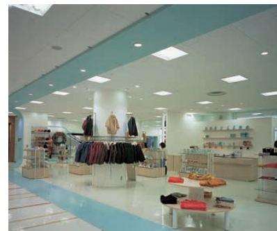
2階テナント Tenant space on the 2nd floor 昼光色(5,000K)のユースクエア器具のベース照明で商品の色を美しく演出し、光ムラのない活気ある雰囲気をつくり出している
