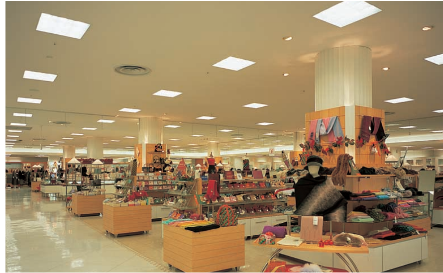
1階テナント Tenant space on the 1st floor ベース照明に昼白色の55Wユースクエア器具を規則配置。圧迫感のないすっきりした天井面の構成で、色再現性のよい(Ra:88)快適で活気ある視環境が実現している
