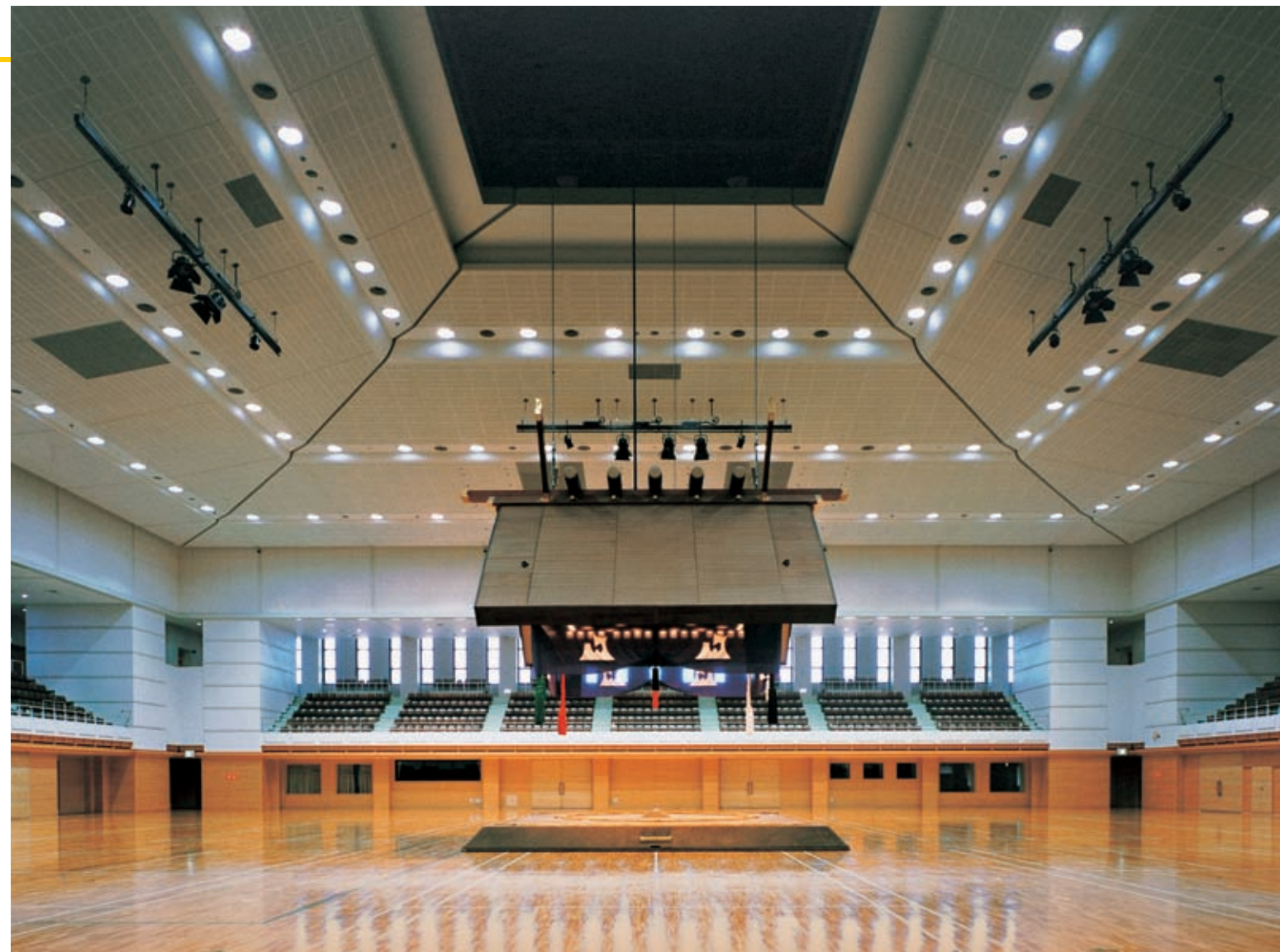
主競技場(相撲用天蓋、土俵を設置した状態) メタルハイドランプ投光器の建築意匠に合わせた角形配置により重厚感のある空間づくりを演出 Main sports stadium (with installation of a decoration roof for the sumo event and the sumo ring)
