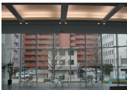
エントランス、打合せ室：間接照明、蛍光灯ダウンライト
