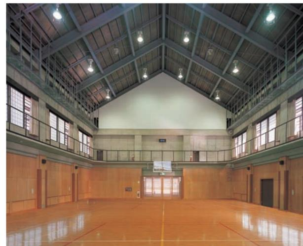
アリーナ照明：電動昇降装置付400Wメタルハライドランプ高天井用反射器具を左右対称に分散配置。全点灯時の初期実測平均照度は1,000 lxが得られている
