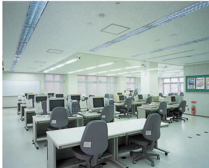
コンピュータ教室の照明：32WHf2灯用埋込アルミルーバ付器具を連続配置。パソコンに照明器具が映り込まないように配慮
