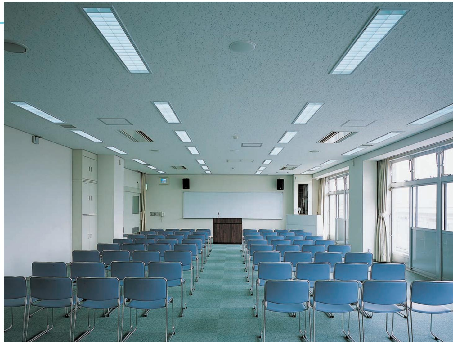
視聴覚教室の照明：32WHf2灯用埋込白色ルーバ付器具を規則配置。学習内容により調光制御で照度を変化させている
