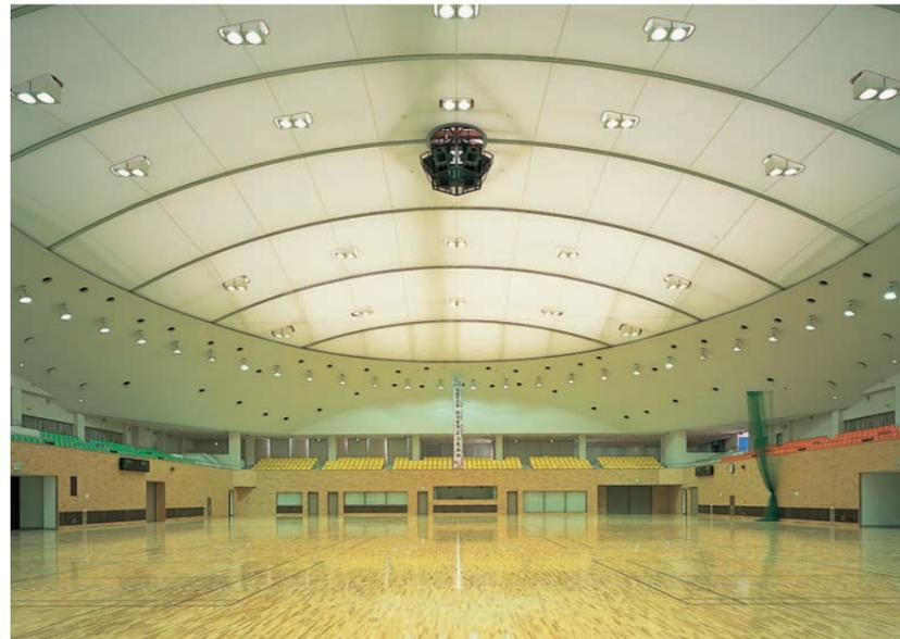
サブアリーナ側から望むメインアリーナ(全点灯時):1kWメタルハライドランプ2灯用バンクライトとアリーナの4方向を囲む1kWメタルハライドランプサイドライトにより均一で明るい照明環境を形成(公式競技時で設計平均照度1,649 lx)
