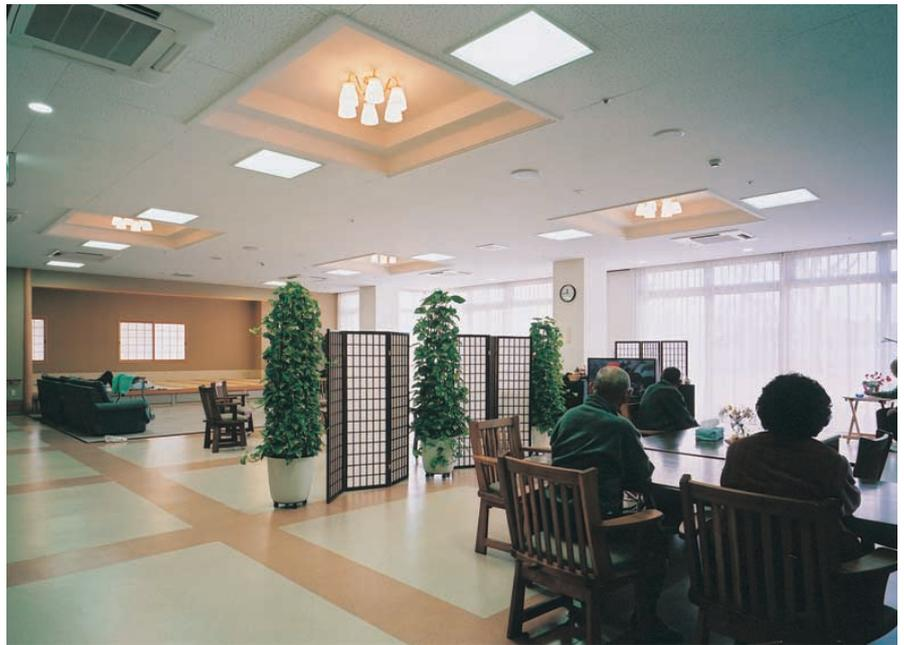
デイサービス食堂、デイサービス作業・機能訓練室：明るさを必要とする昼間は4灯用55Wユーラインコンパクト蛍光灯器具を点け、シャンデリアは消灯。また光センサーにより昼光利用をしている
