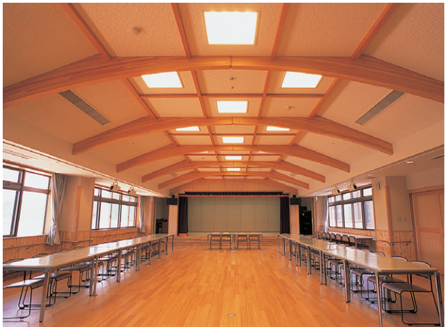
交流ホール：食堂と同様、4灯用55Wユーライン埋込器具（電球色）を配置
