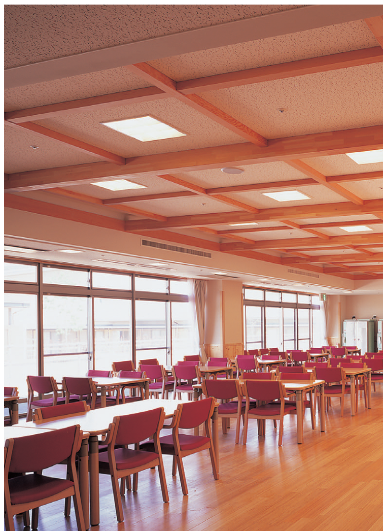
食堂：4灯用55Wユーライン埋込器具を設置。ランプは電球色を使用している
