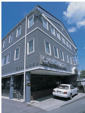
長野県／望月町 信州電機株式会社
