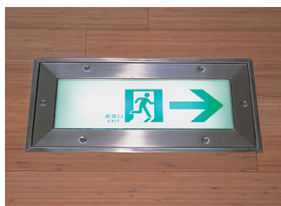
廊下誘導灯：お年寄りの視認性を考慮し、床に埋め込まれている
