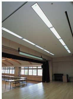
交流ホールステージ：ステージ用照明として、2灯用Hf32W蛍光灯ランプ埋込器具調光形（ルーバ付）を設置
