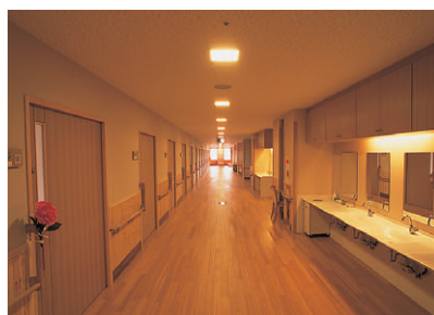
廊下：2灯用27Wユーライン埋込器具を使用。手洗いコーナーは間接照明としアクセントをつけている
