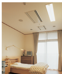
2階居室：Hf32W2灯用ルーバ付器具を主照明にして13Wコンパクト形蛍光灯電球色のアーム式ベッド灯を設置
