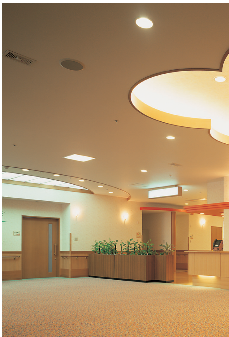
ロビー：クローバー形の折り上げ天井に、60W形ミニクリプトンランプ6灯用の和風セミアオー
