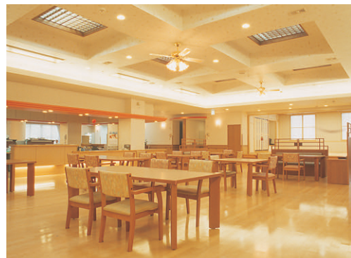
1階のデイサービスフロア：周囲に間接照明を施した格子天井は、マス目内に建築化照明を設けて高さを演出
