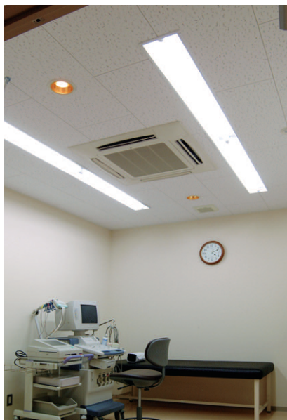
超音波検査室/心電図室：Hf32W2灯用埋込器具“Hf-Lcoフリー-V”の他、調光可能なダウンライトを設置している
