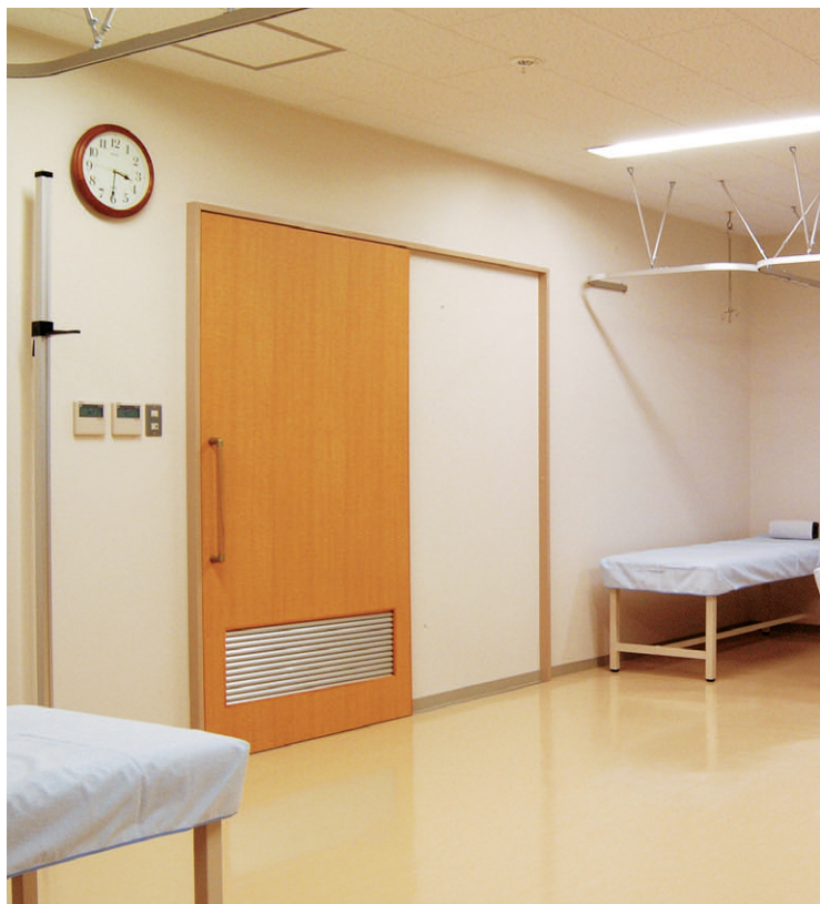
Hf32W2灯用埋込器具“Hf-LcoフリーV”を使用した診察室の照明。ベッドに寝た患者に眩しさ
