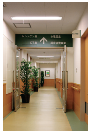
廊下：2灯用および1灯用Hf32W埋込器具を設置。2灯用は電圧フリーの“Hf-LcoフリーV”、1灯用は電圧・ランプフリーの“Hf-LcoフリーV・L”を使用
