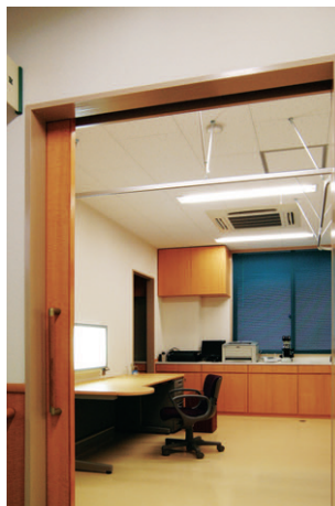
処置室：診察室と同じく、Hf32W2灯用埋込器具“Hf-LcoフリーV”を使用。医師の書き込み作業にも充分な照度を得ている
