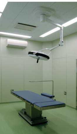
手術室：Hf32W2灯用埋込器具（カバー付）は調光可能タイプを使用している
