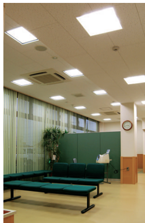
待合室：Hf32W4灯用埋込器具（バツフル付）を配置。全体的に埋込器具を使用することで、リラックス感を高めている
