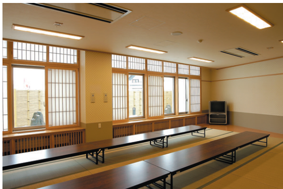
教養娯楽室：32W Hf蛍光ランプ埋込器具（カバー付）を使用し、落ち着ける空間としている
