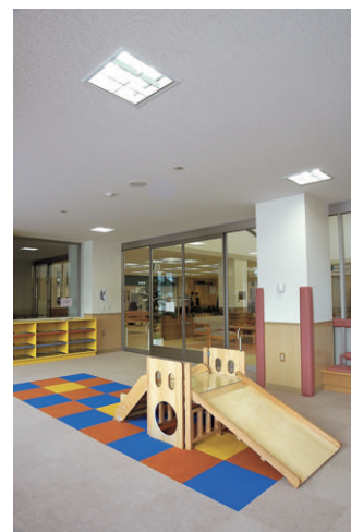
プレイルーム：子供の目線でもまぶしさを感じさせないようルーバ付器具を使用
