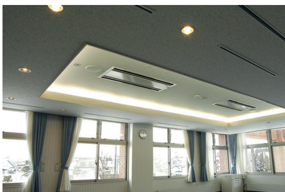
研修室：32Wコンパクト形蛍光ランプダウンライトは調光可能となっている
