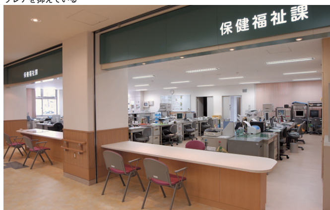
事務室：32W Hf蛍光ランプ埋込器具（ルーバ付）の採用で、OA機器への映り込みを減らし作業効率をアップ
