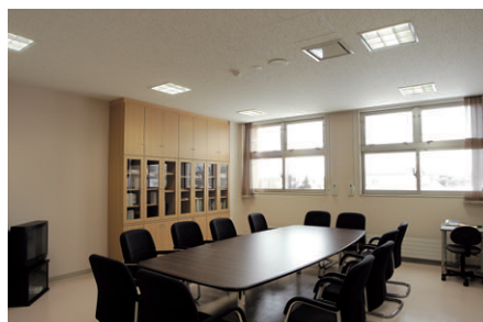
ボランティア室：32W Hfコンパクト形蛍光ランプ埋込器具（ルーバ付）を使用
