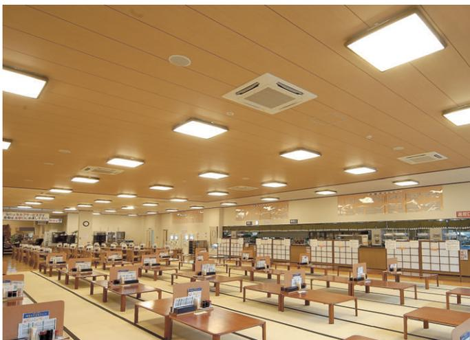
食事処「白磁亭」：24W形Hf蛍光ランプ6灯用直付シーリングライトを44台設置
