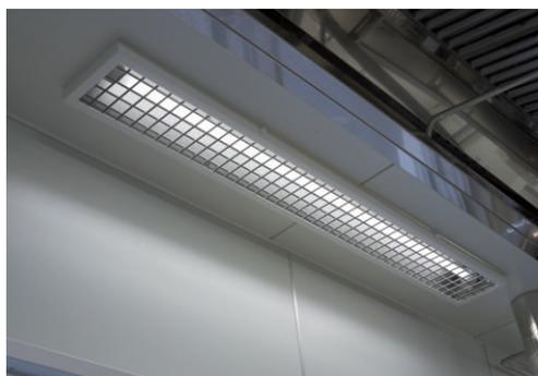
鍋の上にある照明器具は攪拌用の棒による破損を防ぐため、特注ガードを使用
