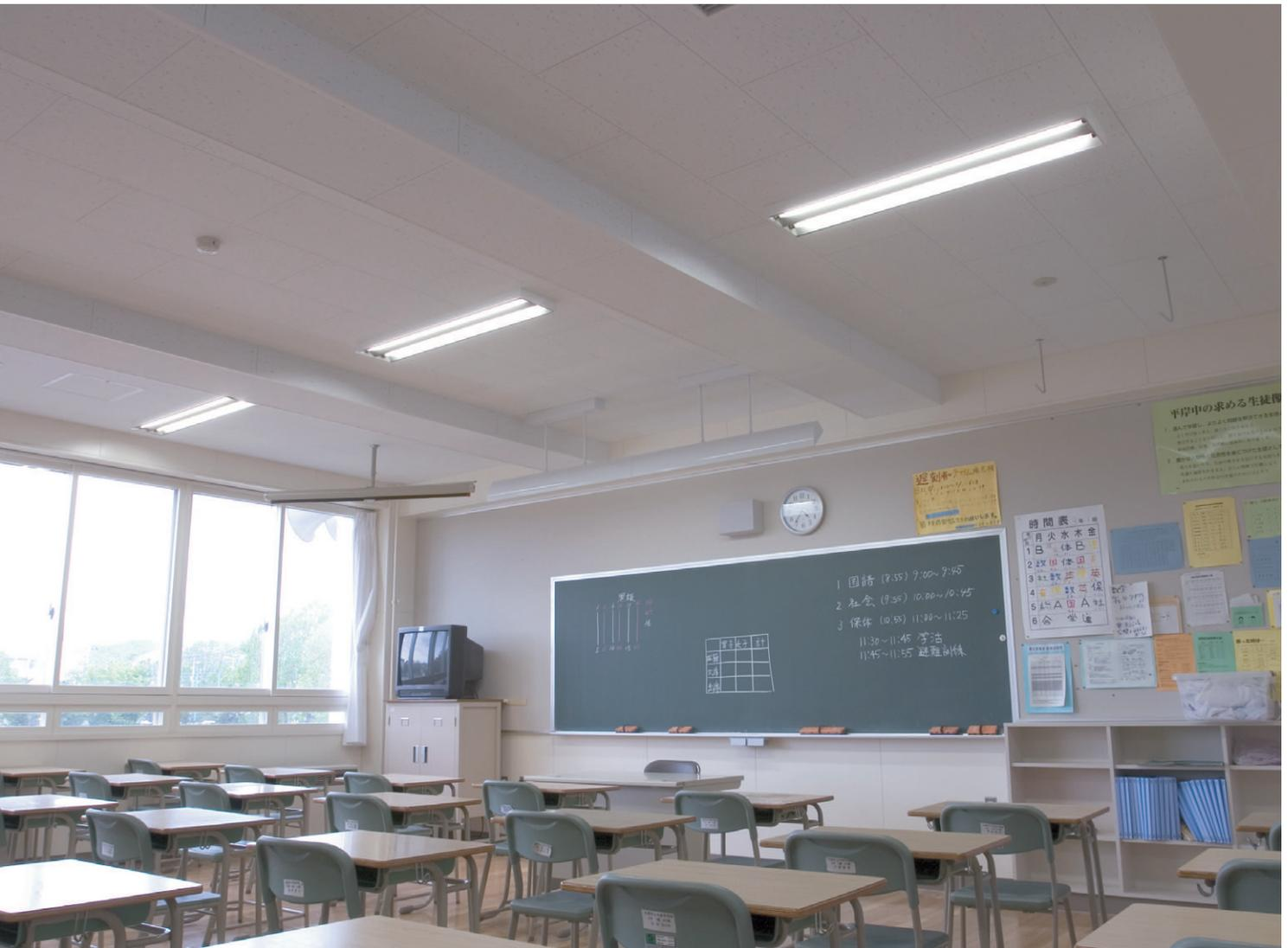
普通教室：32W Hf蛍光ランプ2灯用教室専用器具(直付形)を6台設置している
