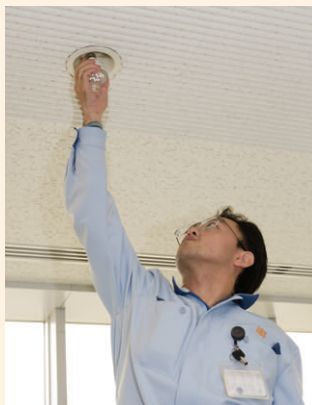
▲交換風景 交換作業をされた太田さま。「作業者3名で、約3時間足らずで300個のLED電球を交換できましたよ」地球温暖化防止グループ 太田 拓児さま
