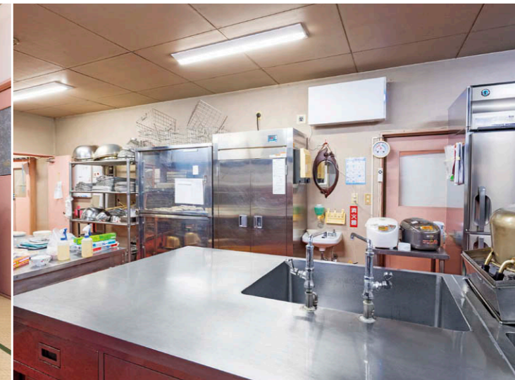
厨房には壁掛けタイプ UVish ②を設置。
