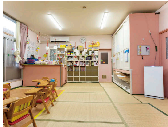
各保育室に1台ずつ設置されている UVish ①
