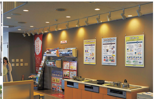
エコ商品展示コーナーの照明 LEDダウンライトとスポットライト（LED電球ミゼットレフ形）を設置
