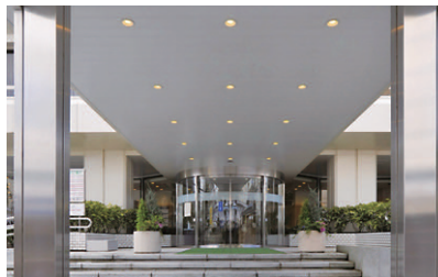
軒下用LEDダウンライトを採用したピロティ
