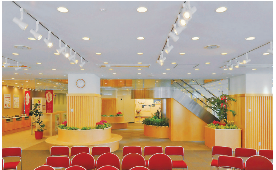
展示・イベントホールの照明 用途による使い分けを可能にするため、LEDダウンライト900シリーズとスポットライト（LED電球ミゼットレフ形）を採用
