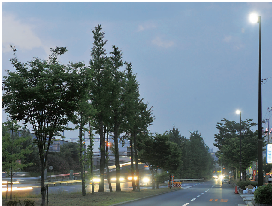
LED屋外照明器具が採用された大阪中央環状線守口市～門真市間の道路照明
