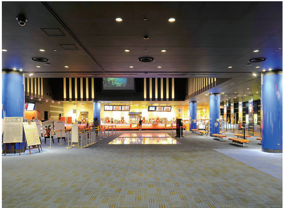
ロビー・エントランス周辺の照明 ダウンライトに使用されていた白熱灯をLED電球に更新、同等以上の明るさを確保しつつ、省エネを実現
