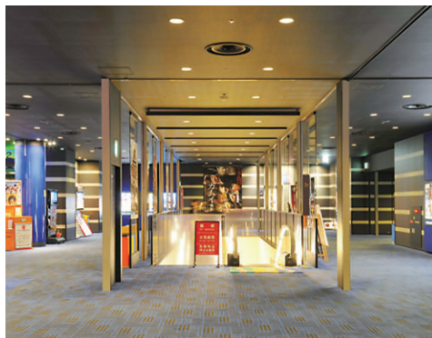
ダウンライトの光源をLED電球に更新したエスカレーター周り
