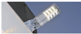
アーケードの車道側に採用されたLED防犯灯
