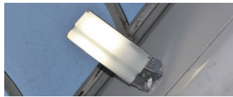
アーケードの軒下に採用されたLED屋外用直付器具乳白カバー付
