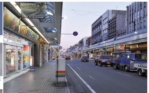
LEDを光源にしたアーケード照明は、夜間も明るく安心して通れると商店街の利用者に好評
